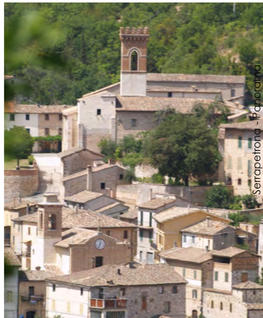
Serrapetrona - Chiesa di San Francesco
